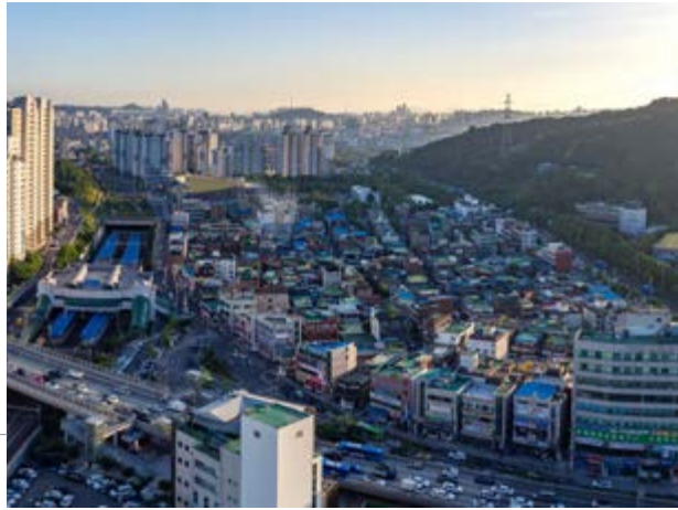
백운역 앞 십정동 재개발구역 철거 전 모습
