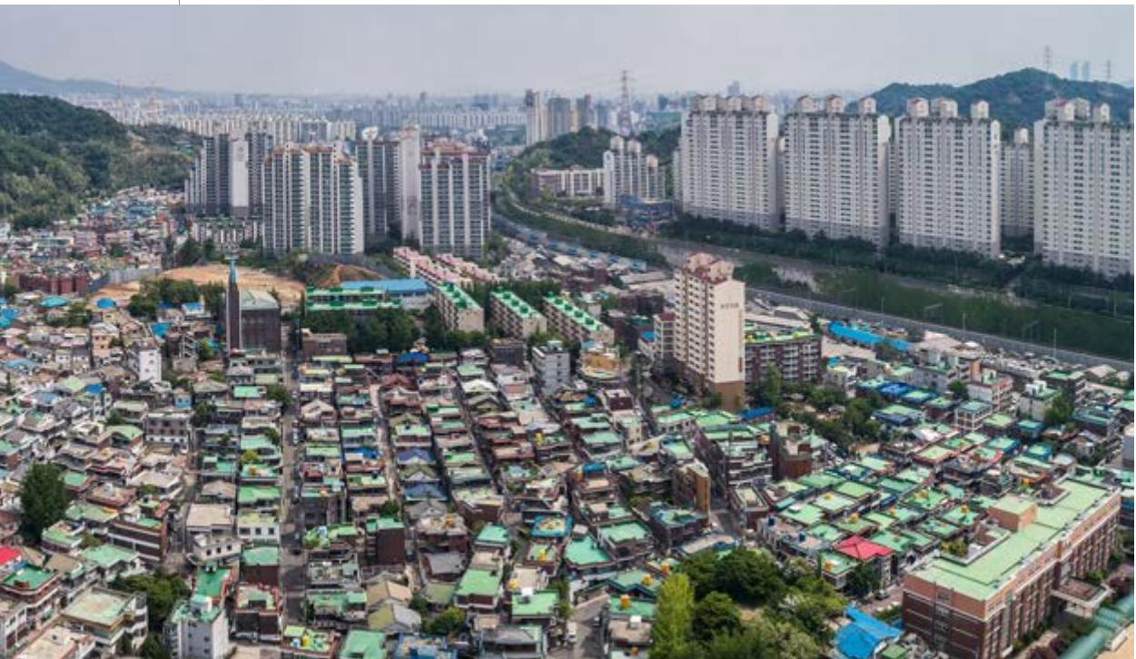
십정1동 _ 열우물마을 전경(철거 전)
