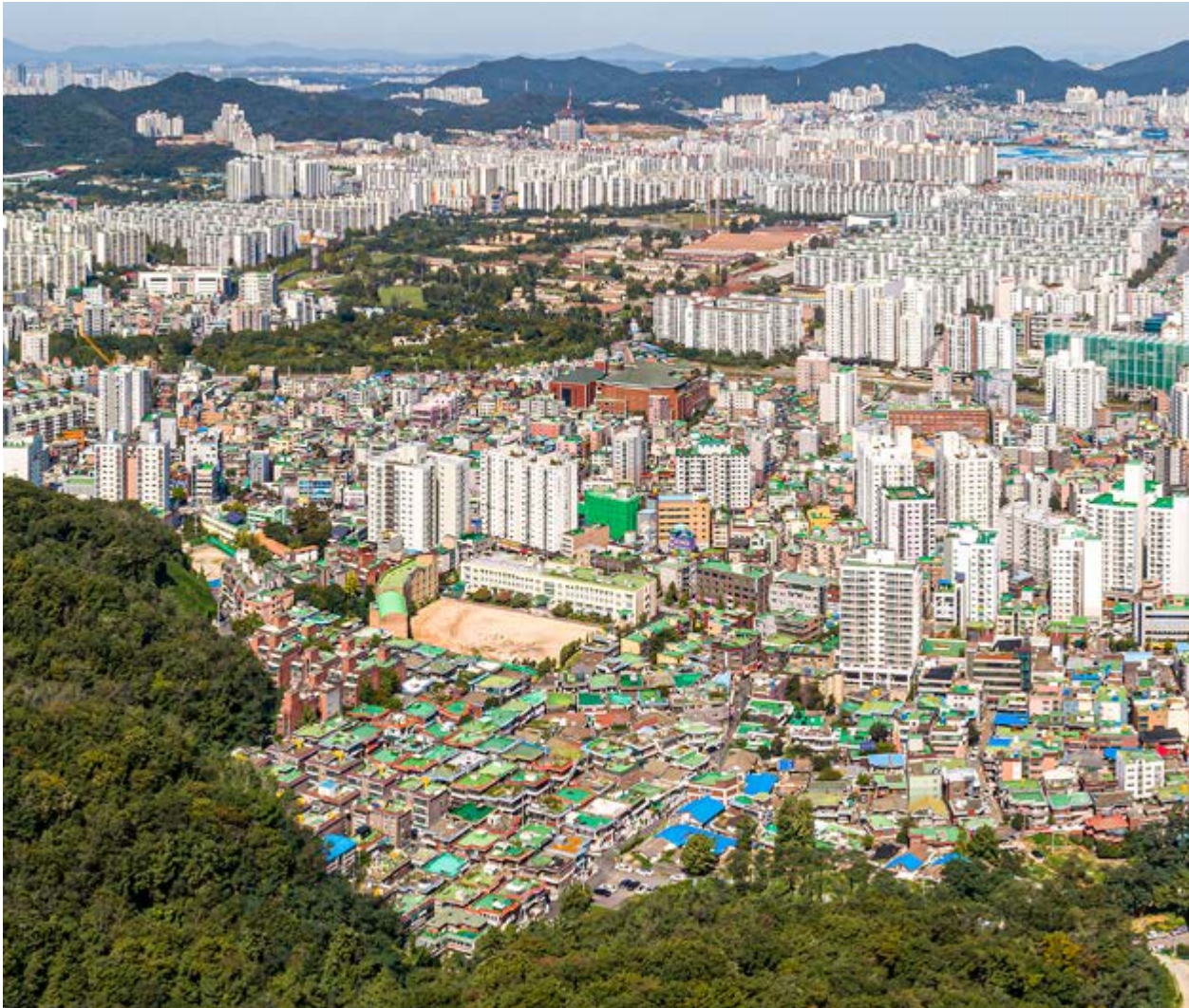
부평2동 _ 철거 전 모습
