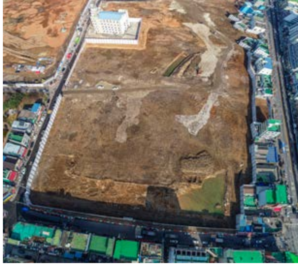
청천1동 _ 2020년 김정사택마을 철거 후 모습
