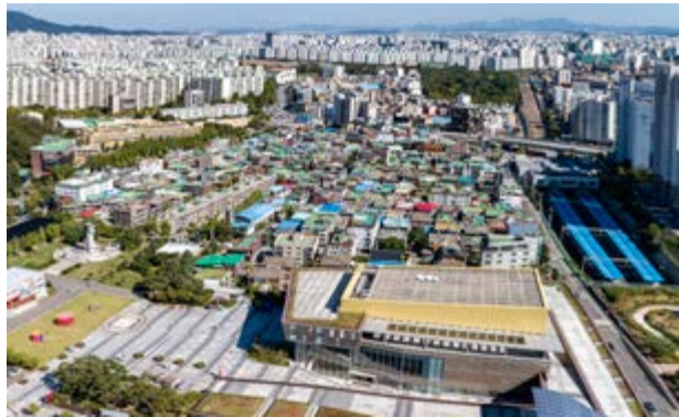
백운역 앞 십정동 재개발구역 철거 전 모습
