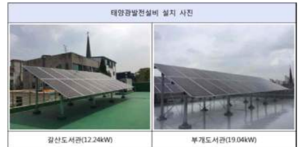
❖ 갈산도서관과 부개도서관에 설치된 태양광발전 설비 ❖ 출처: 인천광역시 부평구, 『2019 규정백서』, 2020, 380쪽
