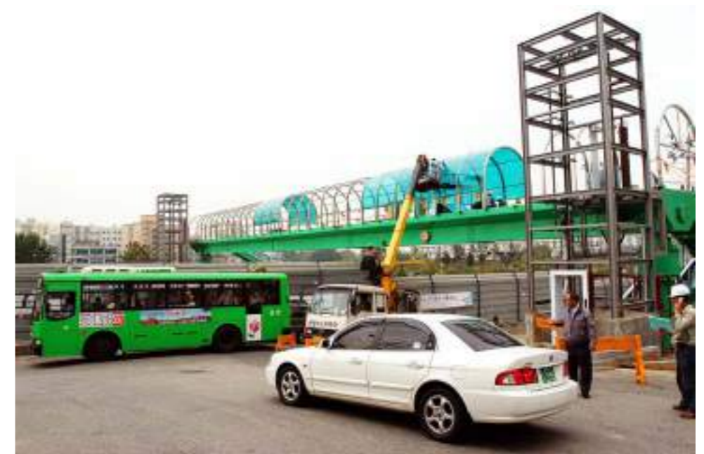
❖ 2005년 부평2동 도보육교 설치 작업(출처: 부평구청)
