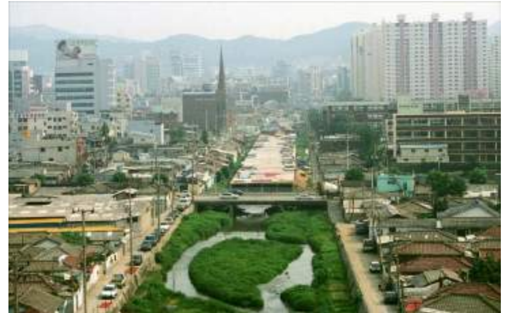
❖ 1996년 부평1동 굴포천 복개 공사 모습(출처 : 부평구청)
