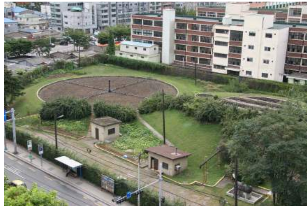
❖ 캠프 마켓 오수정화조 부지 전경
