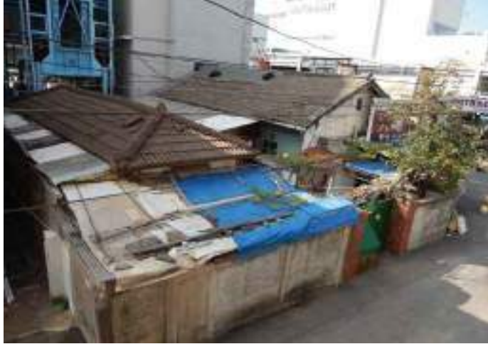
❖ 부평 철도관사 전경(출처 : 인천광역시립박물관)
