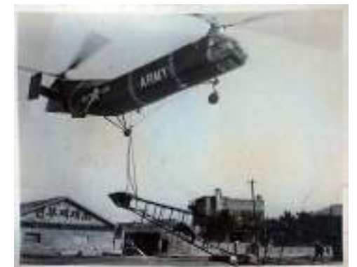
❖ 미군이 헬기를 지원해 신촌성결교회 철탑을 올리고 있다(신촌성결교회 소장)(출처 : 부평역사박물관, 『이주민의 마을, 부평 신촌』, 2015, 127쪽).
