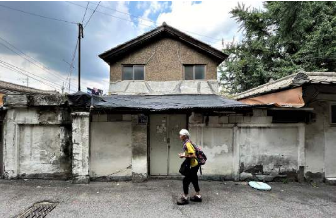
❖ 그 집 앞 오가다 보니 어느덧 내 머리에도 서리 내렸네 (산곡동)
