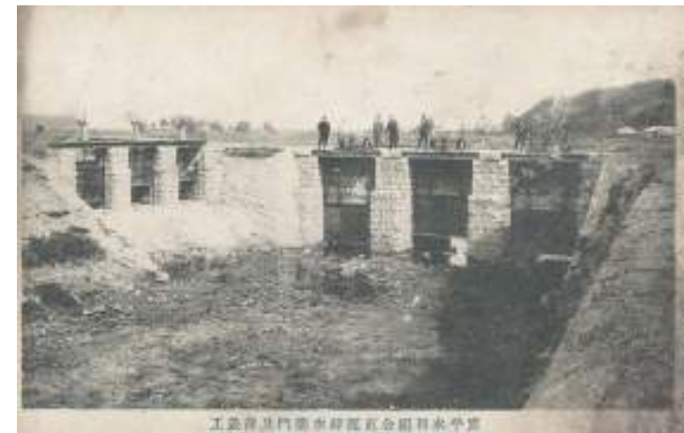
◆ 부평수리조합 동부 배수갑문 및 바닥보호 공사(출처: 부평역사박물관)
